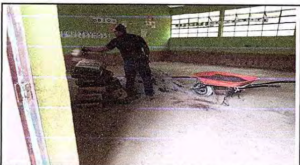
Foto 3: PREPARACIÓN PARA LA COLOCACIÓN DE LA TORTA DE CEMENTO, MÓDULO 2.
