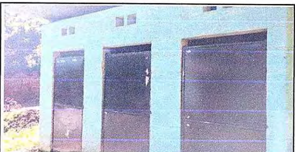
Foto 5: INSTALACIÓN DE PUERTAS, MÓDULO 4.
