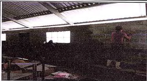
Foto 7: APLICACIÓN DE REPELLO INTERNO, MÓDULO 3.
