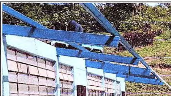
Foto 14: VISTA DE INICIO DEL CAMBIO DE TECHO (LAMINA CAPOTE Y CANALES), MÓDULO 1.
