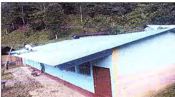
Foto 15: PROCESO DE COLOCACIÓN DE TECHO MÓDULO 1.
