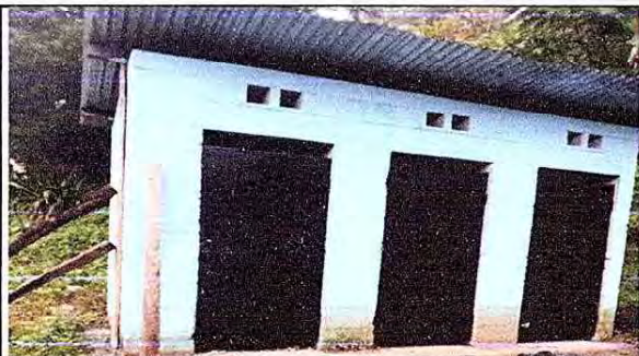
Foto 13: CAMBIO DE TECHO Y COLOCACIÓN DE PUERTAS DE LOS BAÑOS, MÓDULO 5.
