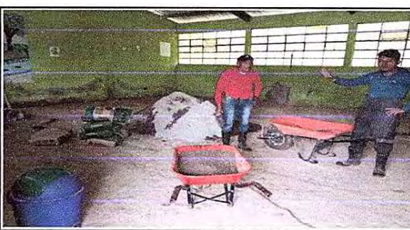
Foto 18: VISTA INTERNA DE AULA, APLICACIÓN DE LA TORTA DE LA TORTA DE CEMENTO, MÓDULO 2.
