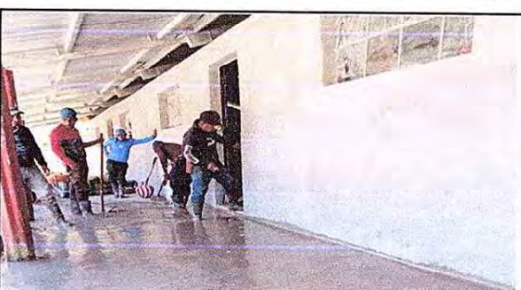
Foto 10: VISTA COMPLETA DE LA APLICACIÓN DE ALISADO, MÓDULO 3
