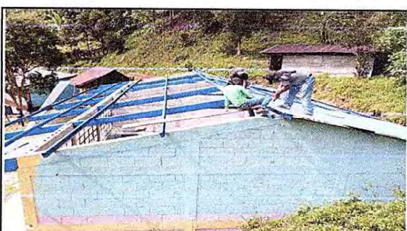
Foto 4: COLOCACIÓN DE TECHO PARA EL MÓDULO 1.
