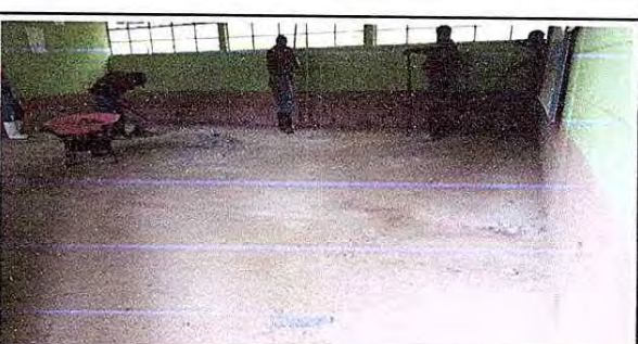
Foto 12: VISTA INTERNA DE AULA EN EL PROCESO DE LA APLICACIÓN DE TORTA DE CEMENTO, MÓDULO 2.
