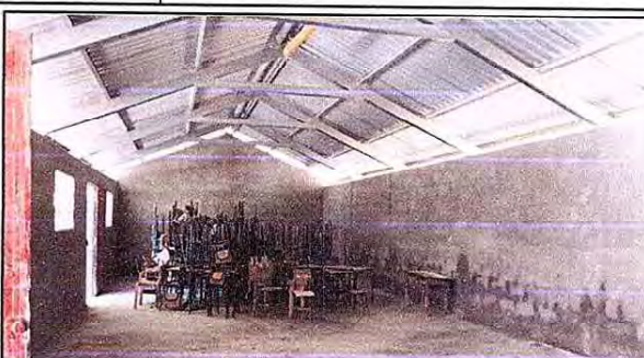
Foto 8: VISTA DEL REPELLO INTERNO, MÓDULO 3.
