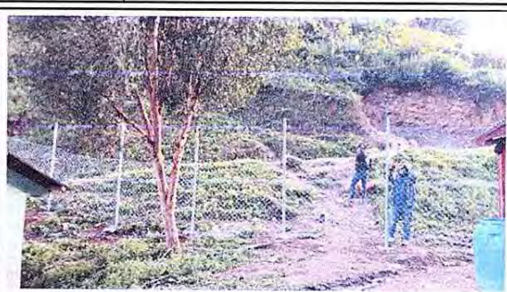
Foto 2: COLOCACIÓN DE MALLA PARA LA CIRCULACIÓN DE LA ESCUELA.
