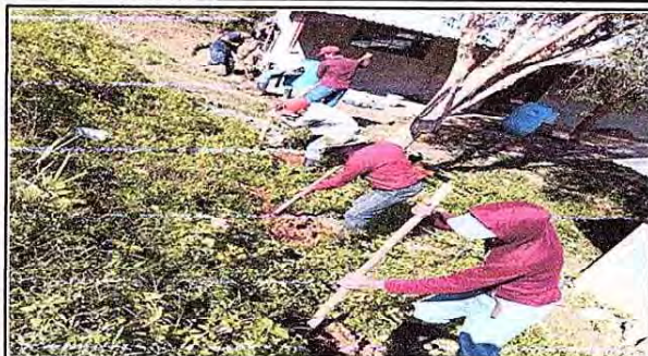
Foto 1: INICIO DE ZANJEJO PARA LA COLOCACIÓN DE TUBOS DE METAL PARA LA CIRCULACIÓN DE LA ESCUELA.
