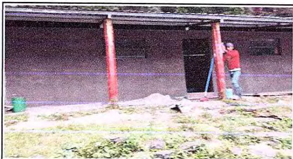
Foto 9: VISTA DE PAREDE CON EL REPELLO, MÓDULO 3.
